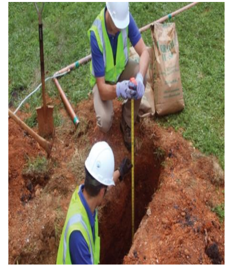
Bước 2: Căn chỉnh kích thước rãnh
