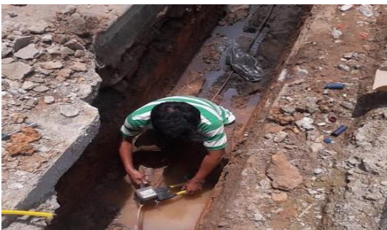
Bước 6: Phủ đất, đo kiểm tra
