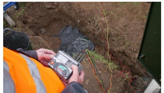
Bước 6: Phủ đất, đo kiểm tra
